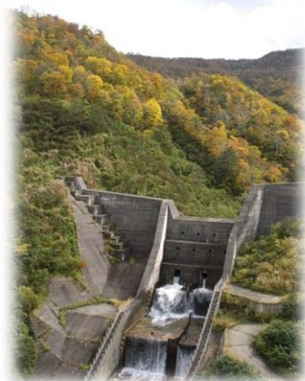
火打山川第一砂防ダム Hiuchi Yamagawa River Control Dam #1
